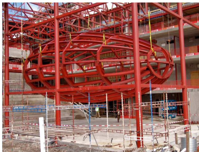
Stålkonstruktionen som utgjorde stommen i Ägget.
